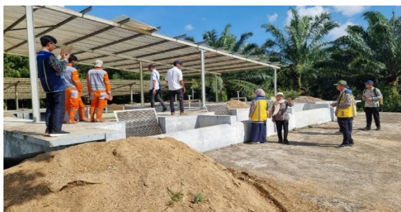
Gambar 3. 7 Kegiatan Penilaian Keandalan Bangunan Sanitasi Tahun 2024
