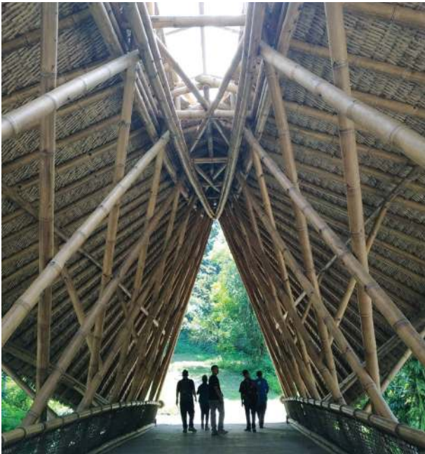
Gambar 2 Penggunaan Bambu Betung sebagai Material Struktur pada Bangunan Jembatan
