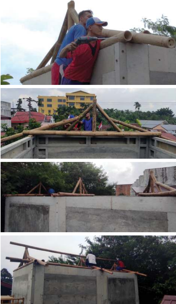
Gambar 8 Tahap Pemasangan Kuda-kuda
