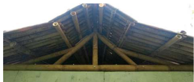
Gambar 12 Tahap Pemasangan Penutup Atap Bagian Puncak
