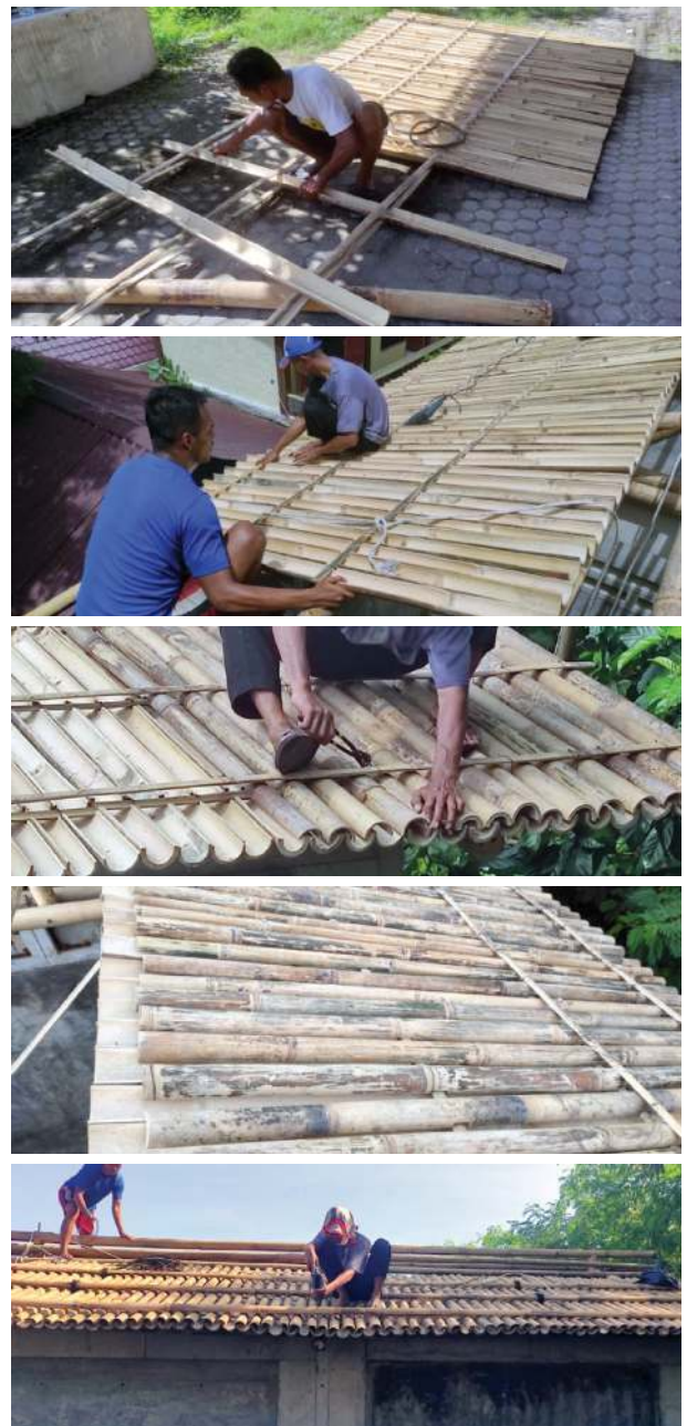
Gambar 11 Tahap Pemasangan Penutup Atap
