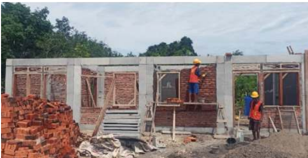
Gambar 10 Perakitan Struktur Panel RISHA
