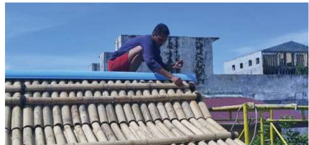
Gambar 12 Tahap Pemasangan Penutup Atap Bagian Puncak
