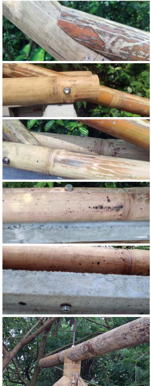
Gambar 9 Bentuk Perkuatan Kuda-kuda
