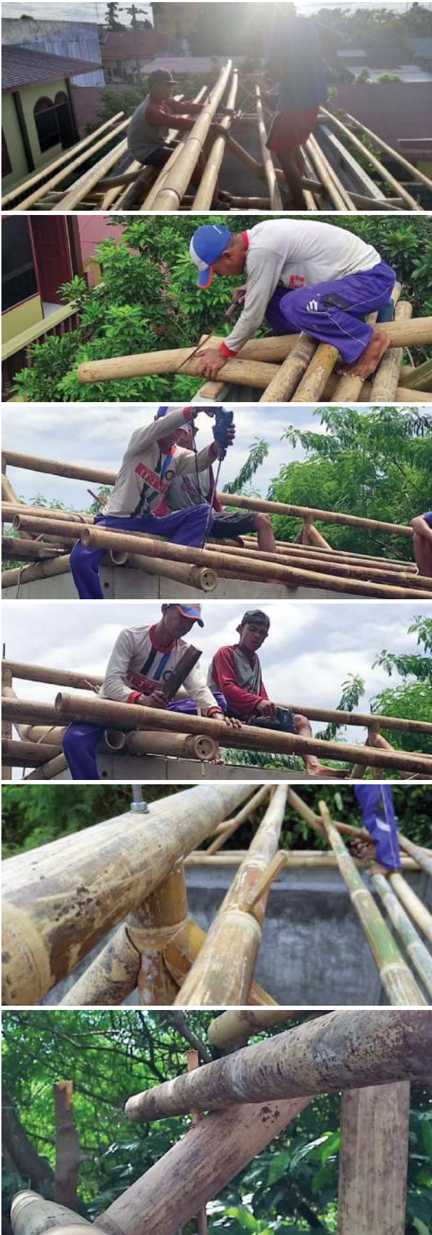
Gambar 10 Letak Perkuatan Gording Ditiap Titik Pertemuan dengan Kuda-kuda Menggunakan Pasak Bambu
