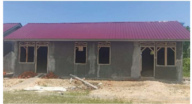
Gambar 11 Pekerjaan Plesteran, Penutup Atap dan Pintu Jendela
