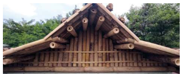
Gambar 13 Tahap Pemasangan Penutup Sisi Segitiga Depan dan Belakang Atap
