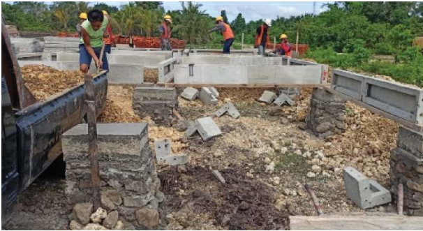
Gambar 9 Pemasangan Pondasi dan Panel P3
