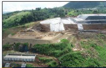
TIMBUNAN BORROW LANDFILL 1A
