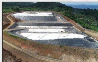
PEMASANGAN GEOMEMBRANE
