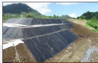
PEMASANGAN GEOMEMBRANE
