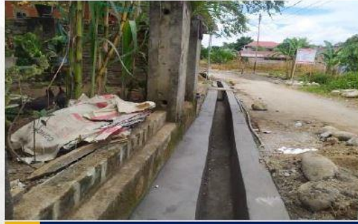
PEKERJAAN DRAINASE TERBUKA
