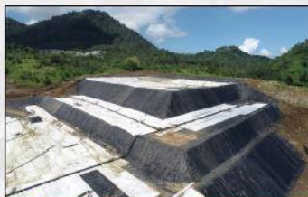
PEMASANGAN GEOMEMBRANE
