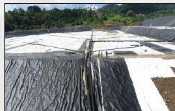
PEMASANGAN GEOMEMBRANE
