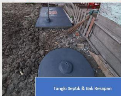
Pekerjaan Jamban, Tangki Septik dan Bak Resapan
