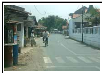
Kondisi jalan Di Kecamatan Plumbon, Kabupaten Cirebon
